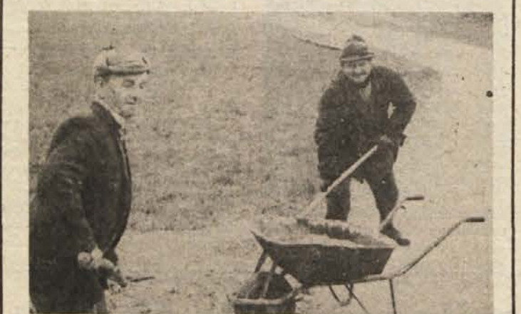
VEDNO NA SVEŽEM ZRAKU — Cestarsko delo je res vedno na svežem in v glavnem zdravem zraku, pozimi pa bi bilo kljub temu lepše delati v zaprtih in ogrevanih prostorih, menita cestarja Črnkovič in Škofca. (Foto: Glavonjič)
