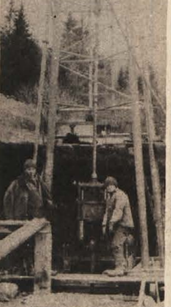
ZA NOVO PITNO VODO — Delavci ljubljanskega Geološkega zavoda noč in dan vrtajo za nove izvore pitne vode v okolici Sodražice.
