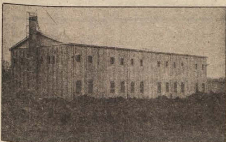
Novo skladišče blagovnih rezerv.
