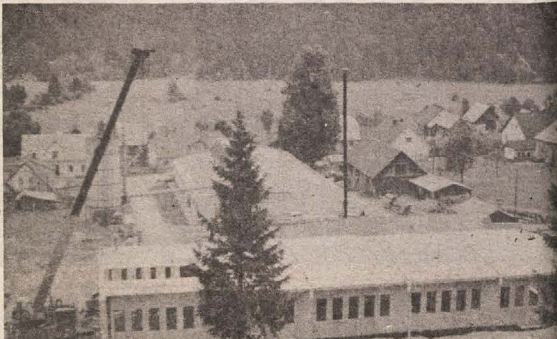
Zadnja faza izgradnje žage v Podpreski, ki bo otvorjena ob proslavi 35-letnice LİK Kočevje
