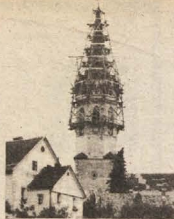
ZA VARNO DELO - Zgornji del kapiteljskega zvonika je že obdan z odri.
