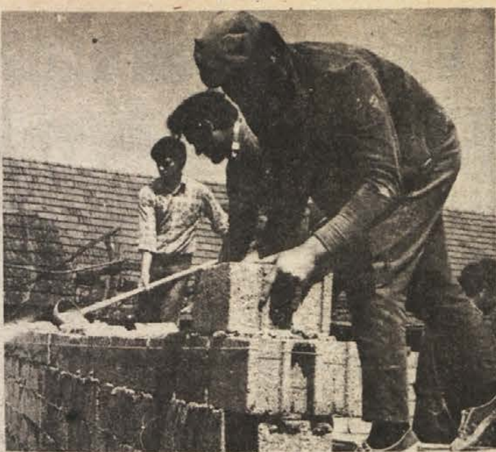
BETONIRANJE ZA PRAZNIK — Boštanjski gasilci udarniško povečujejo svoj dom, ki mora biti nared do občinskega praznika. Do praznikov bi radi opazili za ploščo na dozidanem delu. Pri delu prizadevno sodelujejo tudi krajanje okolških vasi. (Foto: A. Zeleznik).
