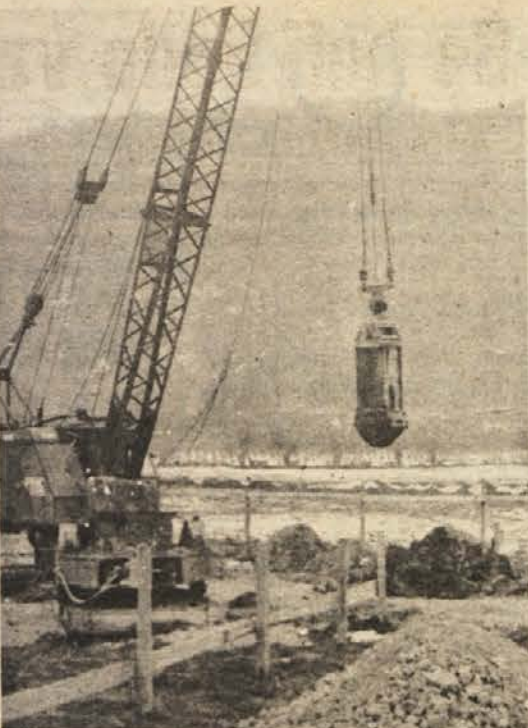
DO NOVE LETINE - SCT Tehnika gradi na Blanci novo skladišče za jabolka. Mercator - sevniški Kmetijski kombinat ga pričakuje že za letošnjo sezono. Gradbinci morajo zaradi slabo nosilnih tal zabijati pilote. Torej se ena pridobitev za to manj razvito krajevno skupnost. (Foto: A. Železnik)
