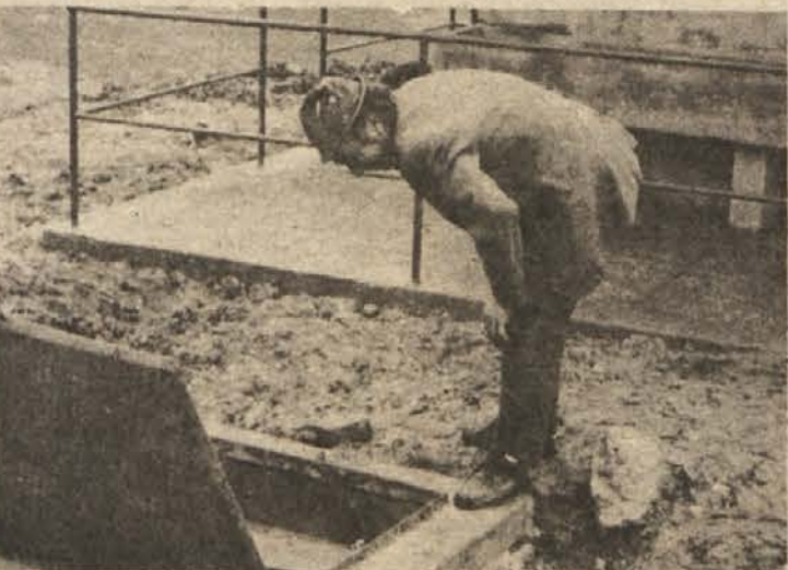
DOGODEK: VODA V ŽABJKU – Te dni so začeli prebivalci romskega naselja Žabjek uporabljati pitno vodo v naselju. Prizadevanja, da bi do tega prišlo, so trajala več let, uspeh pa se je pokazal šele zdaj. Romi so sami izkopali jarko, material in postavitev skupnih pip pod nastreškom pa je bila financirana iz družbenih sredstev. Čez zimo črpajo vodo iz jaska, pipe pa bodo iz bojazni pred zmrzaljo začele delati spomladi. (Foto: R. Bačer)
