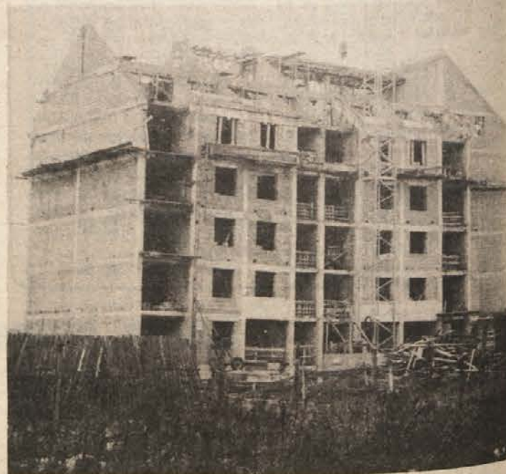
STANOVANJSKA IZGRADNJA – gradnja sodobnega stanovanjskega bloka
