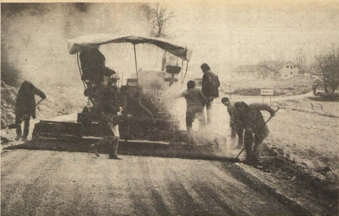
ŠE ZADNJI METRI ASFALTA – V soboto so delavci Cestnega podjetja iz Novega mesta položili še zadnje metre asfalta na približno dva kilometra dolgi trasi od Škranč do Ruperč vrha in tako spojili asfaltni cesti v Birčni in Stranski vasi z Novim mestom. Vsekakor pomembna pridobitev, ki pa je čakala na uresničitev že dobrih petnajst let. (Foto: Tone Jakše)
