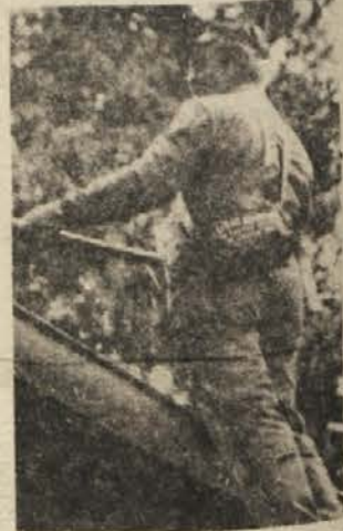
NA STREHI VODOVODNEGA ČRPALIŠČA — Zatesnili so vse odprtine, da bi občane Brežic obvarovali pred radioaktivno nevarnostjo iz JE.
