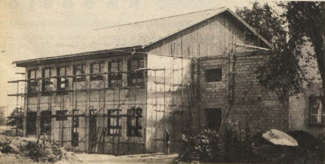
Gradnja otroškega vrtca se približuje h koncu
