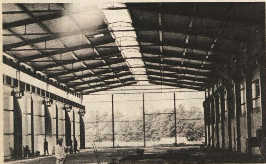
Gradnja industrijske montažne hale
