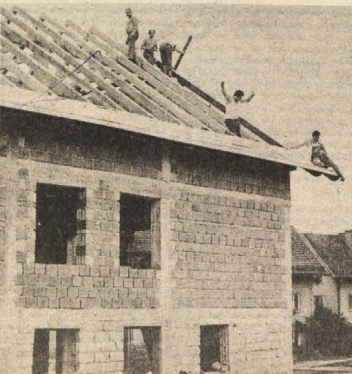
TE DNI BO STREHA: Gasilci in krajinjani Otočca so v zadnjem času po ves dan na strehi nove družbene stavbe, namenjene predvsem gasilcem. Doslej se vsa dela opravili prostovoljno. (Foto: R. Bačer)
