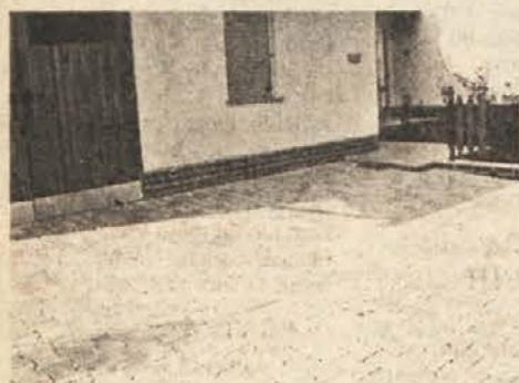
Betonske tlakovce priporočamo za tlakovanje dvorišč, poti, parkirnih prostorov. Tlakovce po potrebi lahko odstranite, nato pa položite v prvotni položaj.
