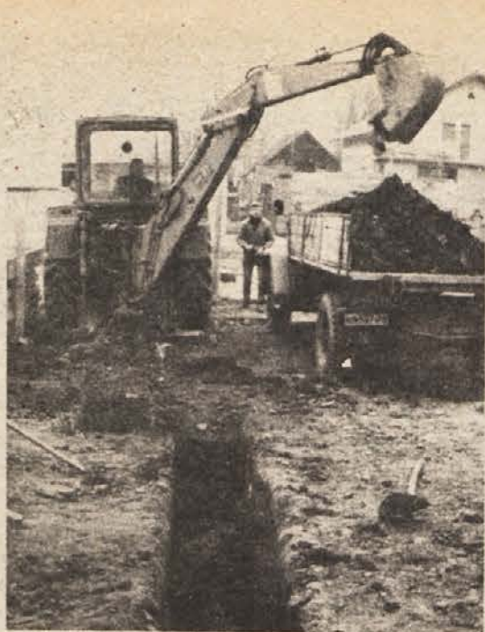
TEMELJI ZA ŠOLO — Sevniška poklicna oblačilna šola zajema učence iz širokega zaledja: od Rogaske Slatine do Zasavja in Posavja. Gradbinci sevniškega Betona so se lotili temeljite prezidave stare zgradbe in dozidave. Konfeksionarke se bodo torej šolale blizu industrije. (Foto: A. Železnik)
