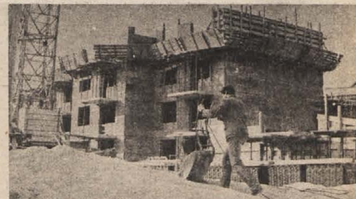
NOVEMBRA BODO BLOKI VSELJIVI — Gradnja treh novih stanovanjskih blokov na Pavlinovem hribu poteka, kot je bilo predvideno. Gradbeni delavci SGP Grosuplje so namreč zaradi mile zime lahko delali skoraj brez zastojev, tako da računajo, da bodo glavna gradbena dela končana do konca letošnjega julija. (Foto: Simčič)
