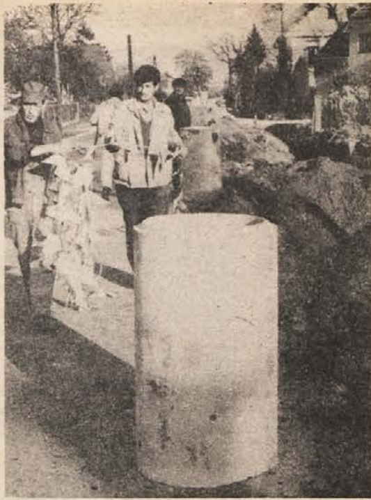
DVE MUHI NA EN MAH — Delavci brežiškega KOP polagajo kanalizacijske cevi vzdolž regionalne ceste skozi Krško vas. Za tem bodo uredili pločnik in tako zavarovali pešce, da bo poslej med njimi manj žrtev prometnih nesreč. Za to delo prispevajo svoj delež tudi krajanji. (Foto: J. Teppey)
