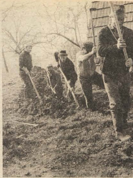
ZADNJI BODO DOBILI VODO — Vaščani Pijane gore edini v krajevni skupnosti Veliki Trn nimajo dovolj zdrave pitne vode. Zato so tudi v nedeljo pridno vihтели krampe in lopate, da bi skopali zadnje metre 2.340 m dolgega voda-oda od zajetja na Novi gori. (Foto: Pavel Perc)
