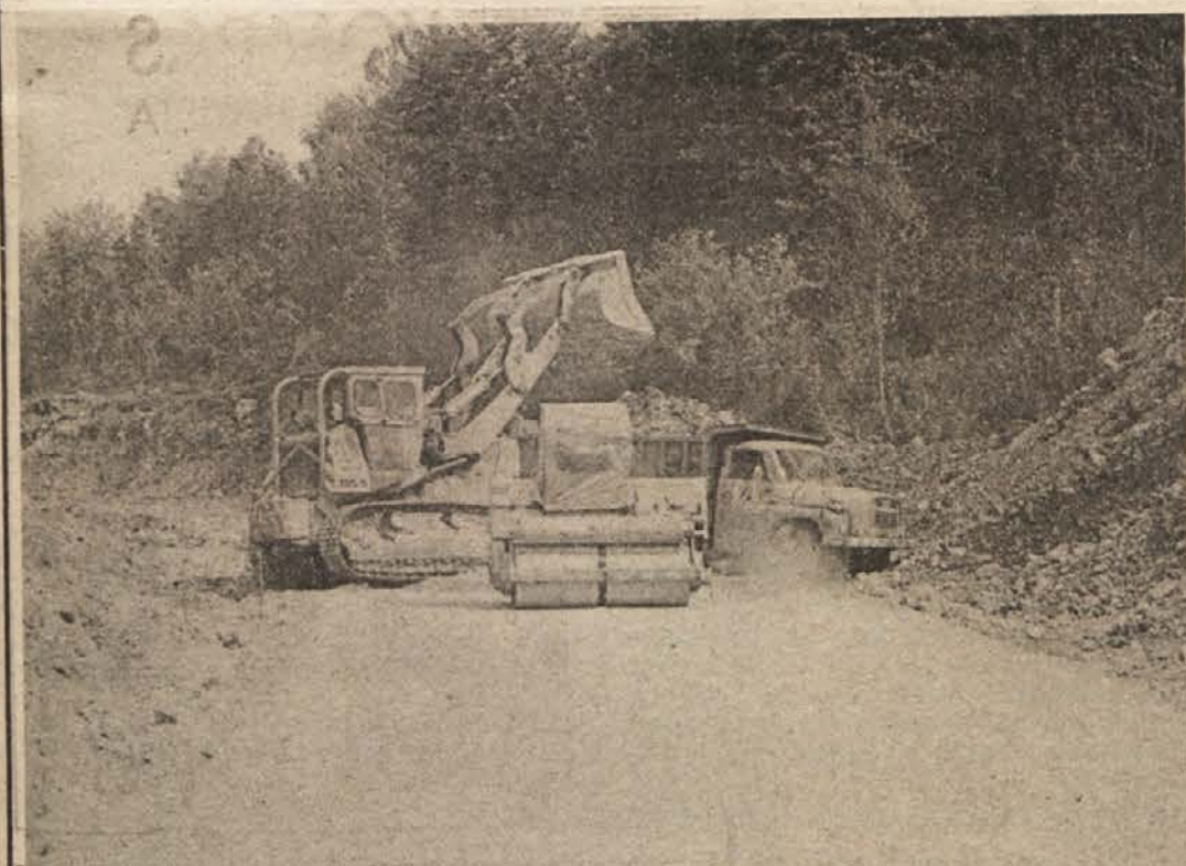
GRADNJA CESTE DVOR – KOČEVJE – Gradbišče odseka Lopata – Lašče
