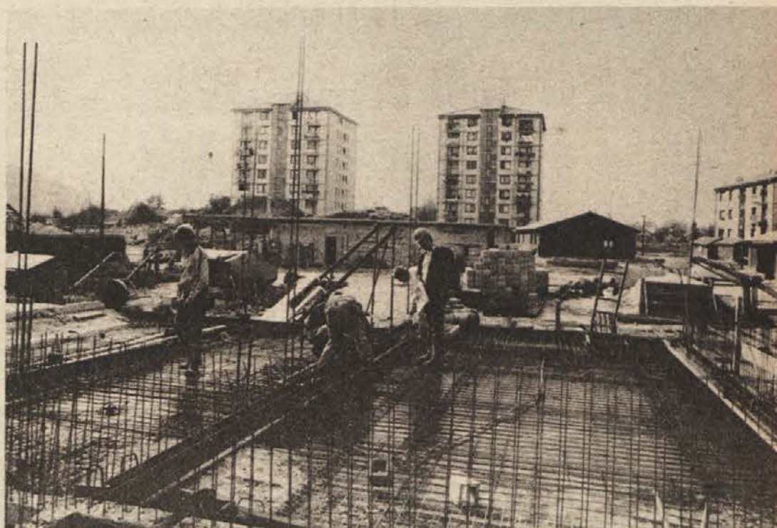
Na gornjem posnetku sta v ozadju dve novi stanovanjski stolpnici P + 7 v brežiški stanovanjski soseski Trnje. Objekta smo zgradili v poldrugem letu, njuna investicijska vrednost je znašala 50 milijonov, stolpnici pa skupaj zajemata 72 stanovanj. Poleg stolpnic pa že gradimo (v ospredju) novo stolpnico in dva stanovanjska bloka s skupno 84 stanovanji. Predvidena vrednost objektov je 100 milijonov dinarjev, rok izgradnje pa je september 1982. V teh novih objektih bosta tudi dve zaklonišči za celotno novo naselje.
