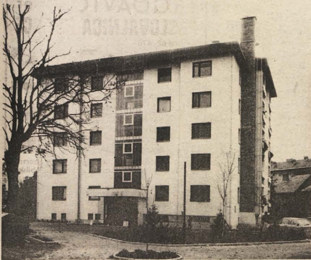
Konec lanskega leta smo v Brežicah zgradili stanovanjski objekt P + 4 z 22 stanovanji. Investicijska vrednost objekta je znašala 20 milijonov din, zgradili pa smo ga prej kot v enem letu.
