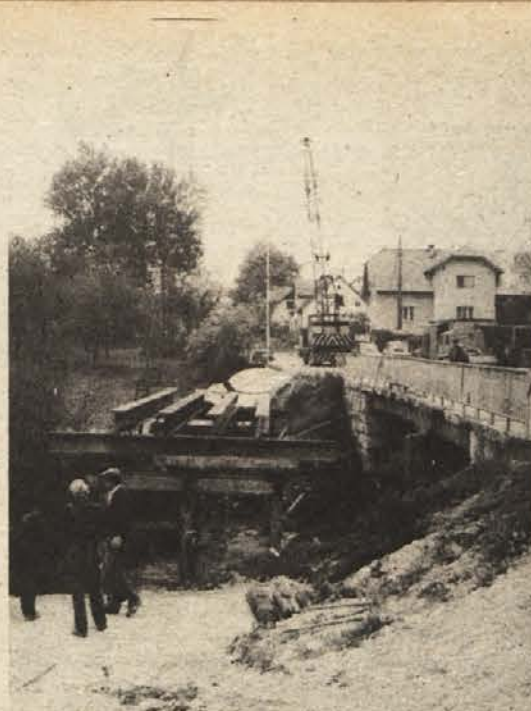
STAREGA BODO ZAMENJALI – Trideset let stari betonski most čez Težki potok v Gotni vasi bodo podrli in do Novega leta na istem mestu zgradili novega. Novi bo republiško skupnost za ceste veljal milijon dinarjev, izvajalci del pa so Gradisovi delavci, ki so za čas obnove že zgradili montažnega. (Foto: Pavlin)
