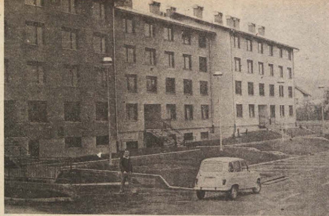
V SOBOTO SLAVI PIONIR — 35-letnico obstoja so pri SGP Pionir Novo mesto z otvoritvijo dveh novih objektov počastili že prejšnji mesec. V soboto, 17. oktobra, pa bo v Domu JLA svečana seja delavskega sveta. Na fotografiji je novi Pionirjev samski dom v Bršljinu, ki je bil predan v rabo v sklopu jubilejnih svečanosti. (Foto: R. Bačer)
