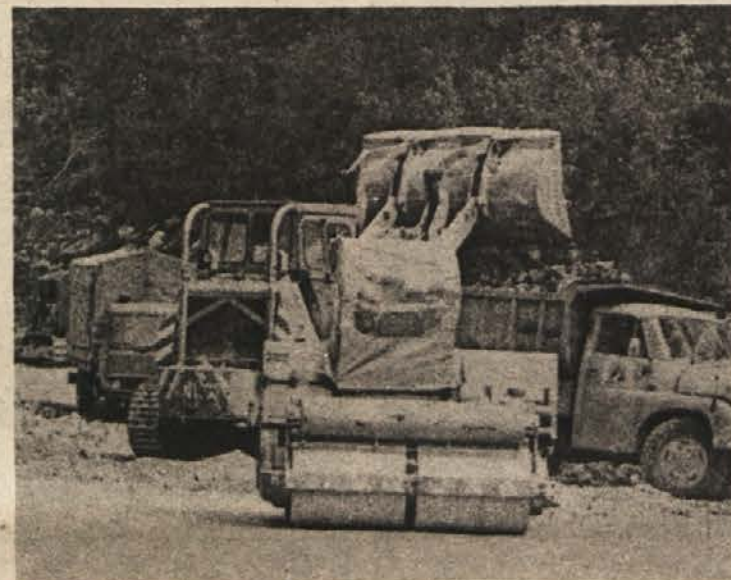
Gradnja ceste Kočevje - Dvor
