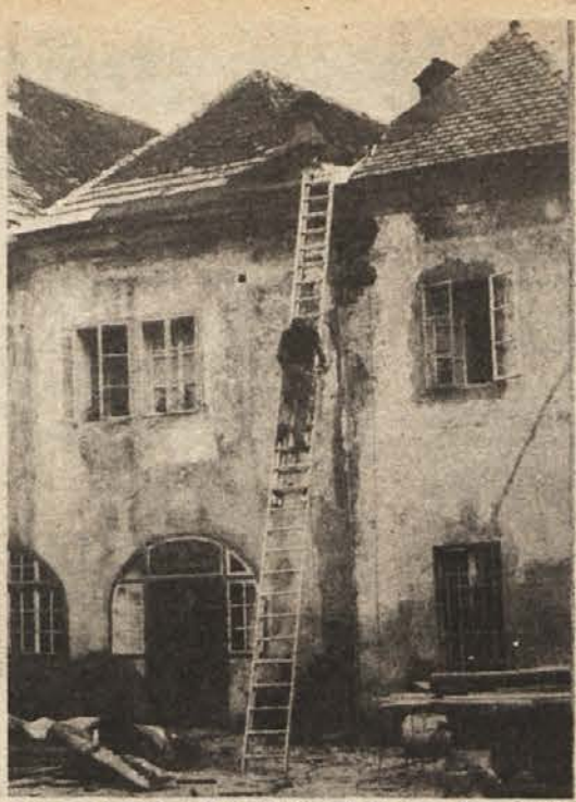
STREHA NE BO VEČ PUŠČALA – To poletje so temeljito popravili streho metliškega gradu na mestih, kjer je voda že začela razjedati ostreže. Medtem ko gredo zunanja dela h koncu, v notranjosti še vedno urejajo prostore za razstavni salon, prvi namenski prostor za likovne razstave. (Foto: I. Zoran)
