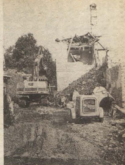
NE GRE ZA OBNOVO — Razpadajoči Seidlov mlin v Novem mestu je sicer predmet javne spotike, nedavno začeta dela ob stavbi pa ne pomenijo obnove in zaščite poslopja, marveč gre za gradnjo „S“ kanala. Ogromne cevi bodo vsak čas položene okrog mesta. (Foto: R. Bačer)
