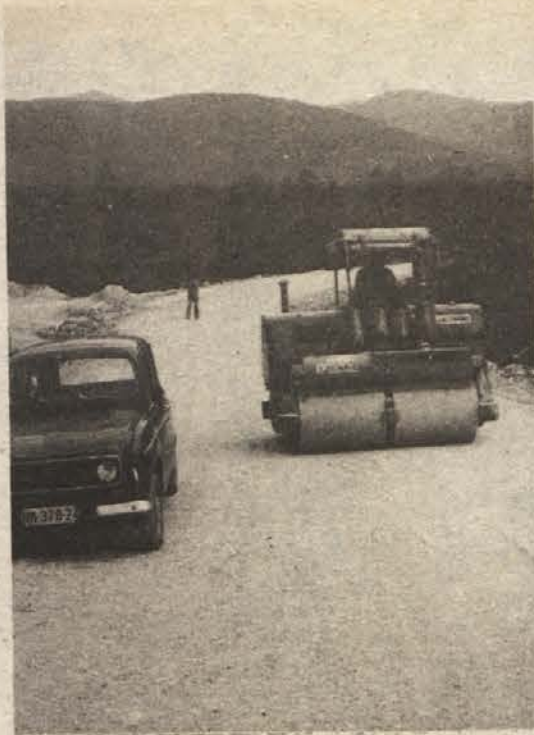
KMALU PO ASFALTU? – Kot je bilo moč izvedeti v Kočevju, gradnja nove ceste med tem mestom ob Rinži in Novim mestom dobro napreduje. Že letos bo menda položen asfalt do Smuke, kako se bodo od tam naprej odrezali Novomeščani, pa še ni znano. (Foto: J. S.)
