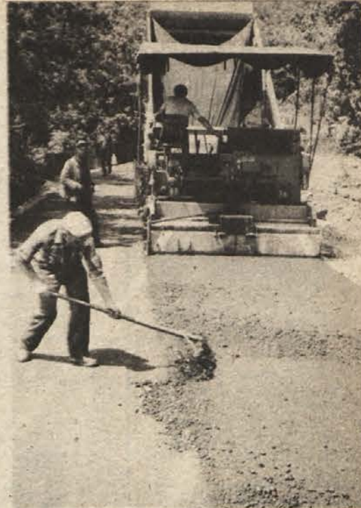
LE VREME NAJ ZDRŽI! – Delavci brežiškega Komunalno-obrtnega podjetja so v soboto hoteli z asfaltiranjem ceste Gadova peč – Vinji vrh – Vrhovska vas. Če le ne bo zagodlo vreme, se bodo ljudje na spominskem območju Žumberak – Gojanci že te dni veselili dveh kilometrov asfalta. (Foto: P. Perc)
