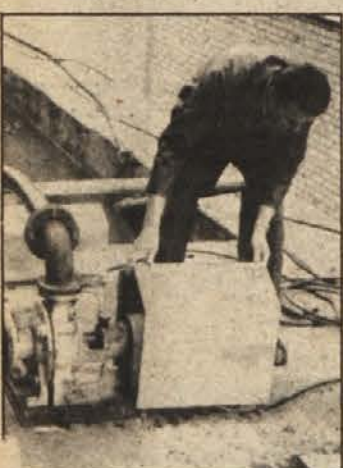
LIMA IZ RIBNIKA – Dvoje rpalck, priključenih na sistem ogrevanja, v toplih dneh uspešno hladi zrak v Jutranjki. (Foto: Železnik)
