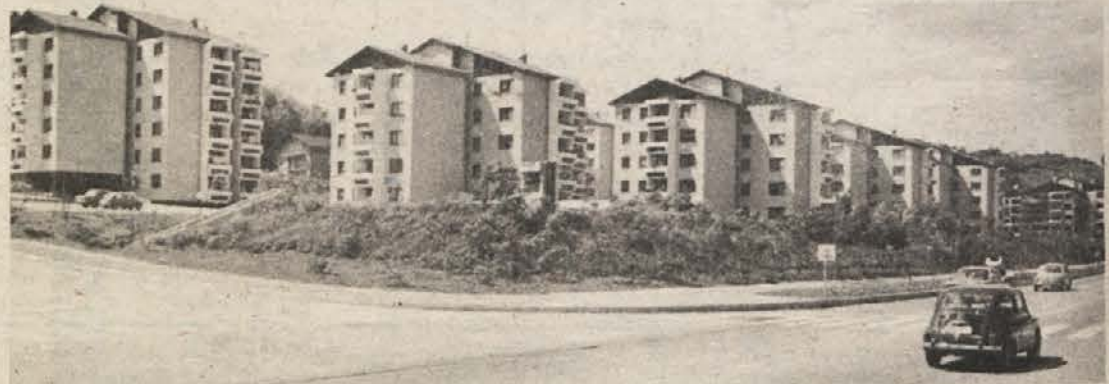
Novo stanovanjsko naselje Spodnji Grič v Krškem
