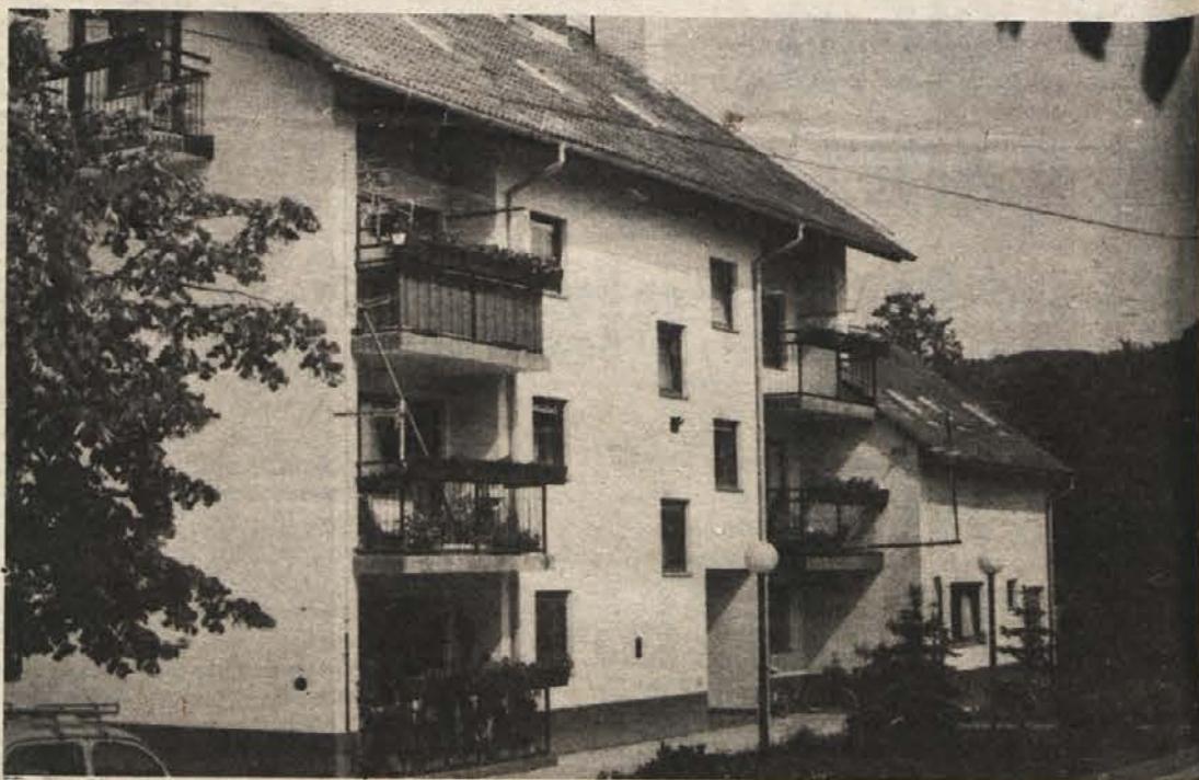
Stanovanjski blok v Kostanjevici
