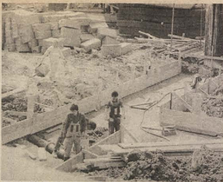
DESET OBJEKTOV V GRADNJI – To je del gradbišča za Krkino ograjo v Ločni, kjer končujejo razne objekte iz programa proizvodnje in predelave bazičnih farmacevtskih surovin. Proizvodnja bo sicer po prvotnem planu stekla z zamudo, bilo pa je pri uvozu opreme toliko zapletljajev, da so jih z veliko težavo prebradili. (Foto: R. Bačer)
