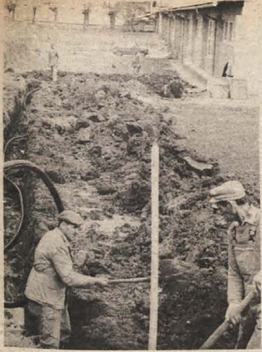
VEČJI METLIŠKI VRTEC — Že lja, da bi otroci dobili prostor v metliškem vrtcu, je veliko več kot prostora, kar seveda že več let vzbuja slabo voljo med številnimi starši. Začetek del za razširitev vrta pa obeta, da se bo stanje vsaj ublažilo, če ne že uredilo.
