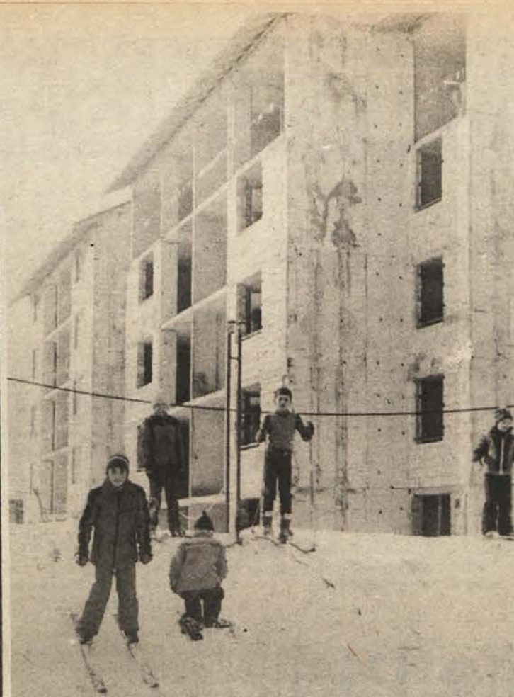
ŠE DVA BLOKA - Na Trgu Veljka Vlahovića grade še dva stanovanjska bloka, ki bosta vseljena predvidoma še letos. Otroci, ki stanujejo v bližnjih novih blokih, izkoriščajo manjšo vzpetinico na tem trgu za smučanje. (Foto: Primc)
