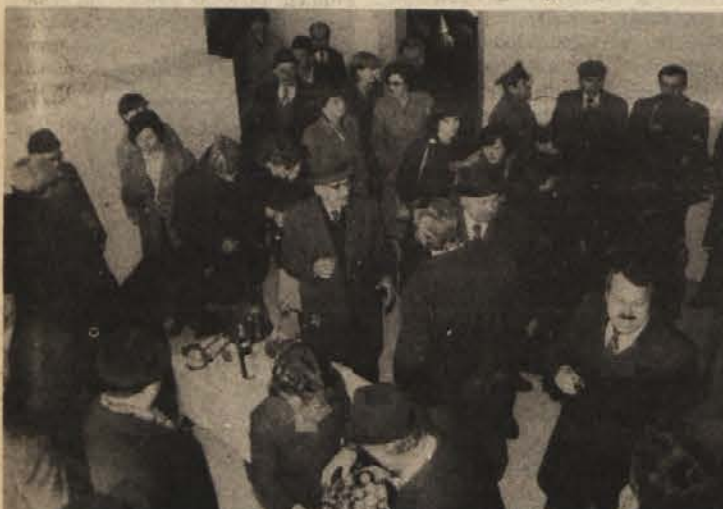
PRVA „ZDRAVILA“ – Osebe, za občinski praznik slovesno odprte nove zdravstvene postaje v Vinici je te velike pridobitve nadvse veselo, gotovo pa si ne želi, da bi bil zdravstveni dom še kdaj tako poln kot na dan otvoritve. Takrat so bili prvi „pacienti“ deležni tudi učinkovitih zdravil, stare domače slivovke, ki menda zanesljivo odganja gripo in – slabo voljo.
