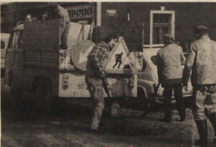
ŠKODA JE VELIKA — Zima je močno poškodovala asfalt v mestu in naseljih, kjer so ceste redno solili. Jame zasipavajo, vendar le začasno, ker se vreme za trajnejše krpanje cest še ni dovolj otopilo. (Foto: J. Teppey)
