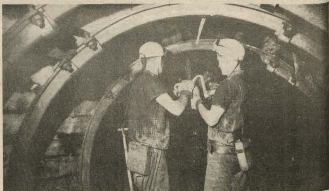
Izkop za jamsko progo
