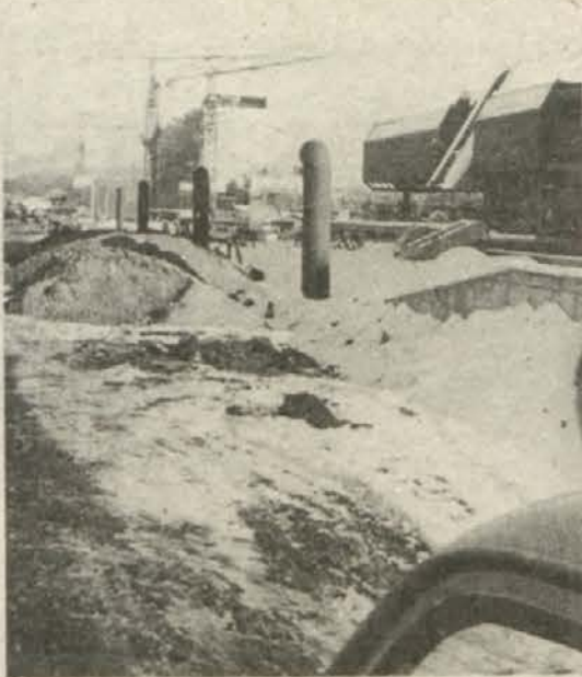
SPOMENIKI PA TA KI – Precej drugačne spomenike, kot jih imajo pokojniki na ločenskem pokopališču, si je privoščil načrtovalec garaže ob novomeški Cesti herojev. Več metrov visoke, na vrhu kot pipe zakrivljene cevi so zračniki, ki kažejo načrtovalceve pomanjkanje čuta za le; o okolje. (Foto: D. R.)
