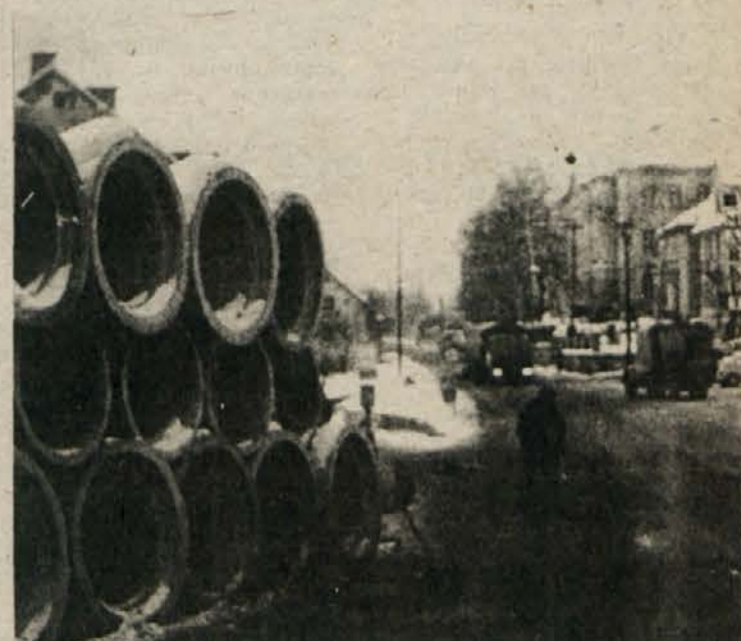
SKLADOVNICA CEVI ZA S KANAL – Ob križišču Ceste herojev in Koštialove ulice je te dni stala gomila betonskih cevi metrskega profila, namenjenih gradnji glavne kanalizacijskega kanala S. Po teh ceveh, ki jih vgrajujejo pod novo cesto, se bodo stekale odplake do ločenske čistilne naprave. (Foto: R. Bačer)
