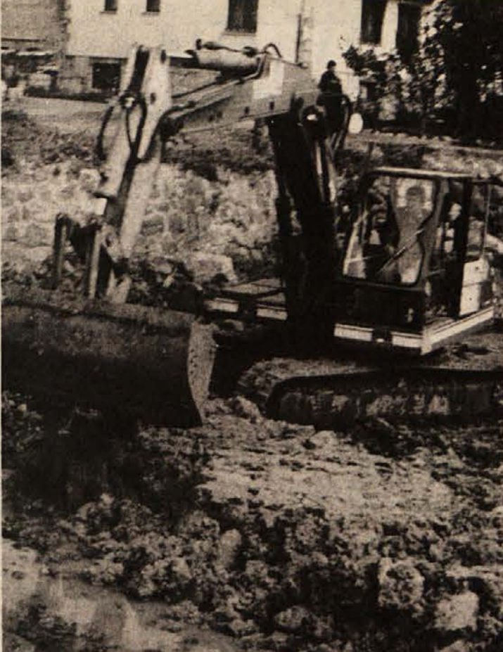
JEZ GRADIJO – V Ribnici so na potoku Bistrica začeli graditi jez. Njegova gradnja je bila načrtovana že več let, a je vedno prišlo kaj vmes, da se ni začela. Zdaj, ko so se dela začela, pa jih ovirata sneg in narasla voda. (Foto: Primc)
