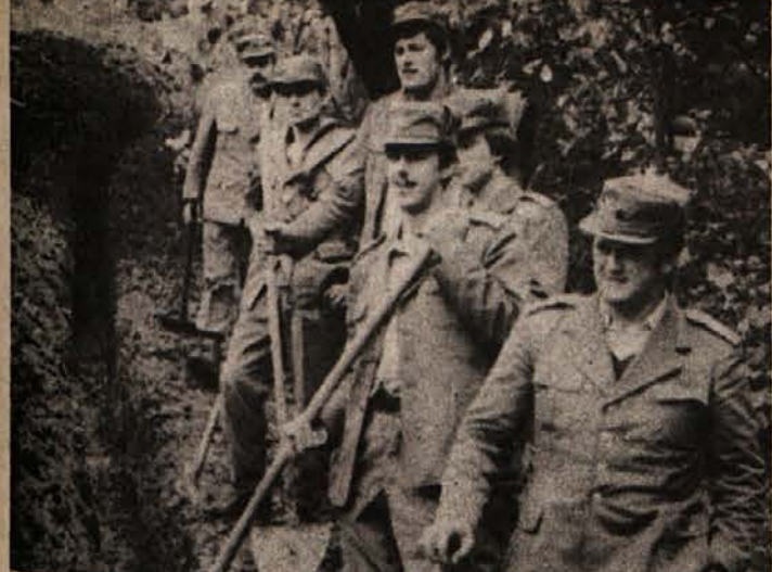
DEŽ JIH NI OVIRAL — Čeprav je v nedeljo, 19. oktobra, deževalo, to ni oviralo miličnikov na delovni akciji v KS Kostel in so jarek za položitev vodovodnih cevi izkopali celo hitreje, kot je bilo predvideno. Po delu so se jim zahvalili predstavniki KS in občine. (Foto: Primc)
