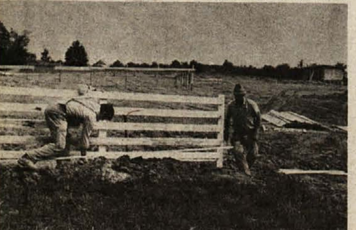
ZA BOLJŠO ELEKTRIKO - V Metliki pripravljajo zemljišče za začetek gradnje nove transformatorske postaje in stavbe Elektra; sedaj metliški električarji gostujejo v zasebni hiši.
