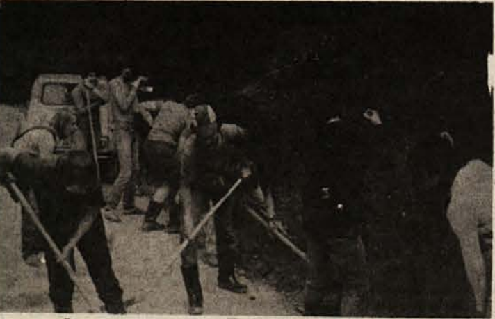
UDARNIŠKO DO NOVE CESTE - 36 brigadirjev MDB „Majde Šilec“ na lokalni MDA „Velike poljane 80“ in delavci ZKGP iz Kočevja zaključujejo dela pri gradnji nove ceste Ortnek-Velike Poljane v dolžini 1.300 metrov. Cesta bo velika pridobitev za krajane, saj bo vožnja zaradi zmanjšane vzpona predvsem pozimi veliko lažja. Do zdaj so brigadirji izkopali obcestne jarke in uredili robnike, čaka pa jih še polaganje cestnih korit, tako da bo cesta pripravljena za asfal tiranje. (Foto: M. Glavanjič)
