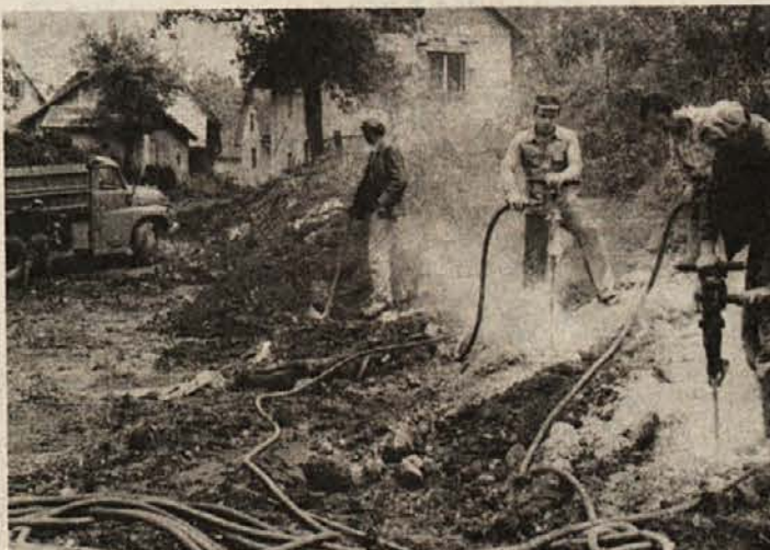
GRADBINCI ČEZ NOČ — Vaščani vasi od Stopič do Zajčjega vrha so se sami lotili obnove in izgradnje ceste, ki jih bo zblížala z dolino. Najtežje delo opravljajo vrtalci. (Foto: J. Pavlin)
