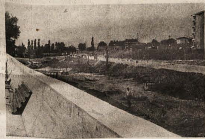
Takšno je videti gradbišče z dela tribune prenovljenega Stadiona Matije Gubca v Krškem. Po besedah organizatorja bo 22. junija stroje zamenjala nova podoba mesta.
