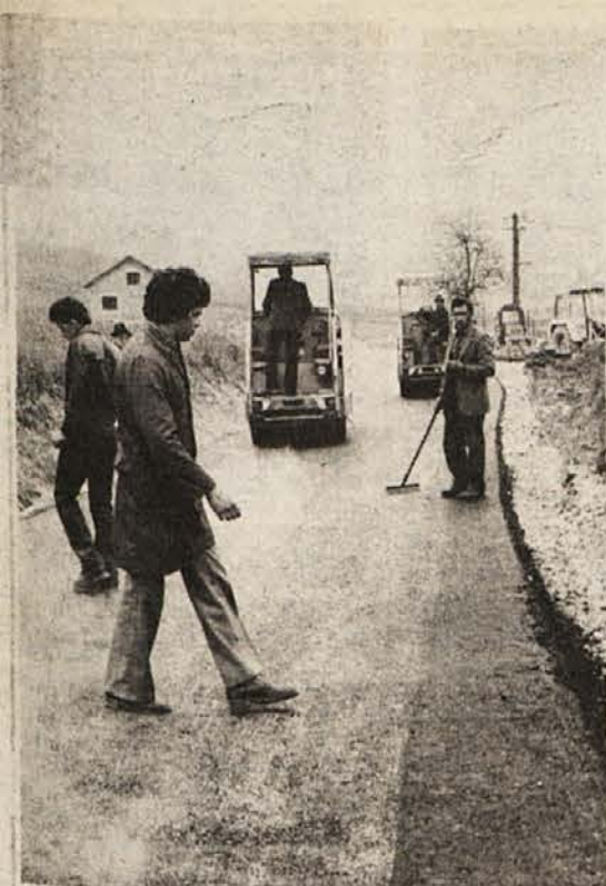
NIČ VEČ PO MAKADAMU – V krajevnem središču Mimi peči in okolici kmalu ne bo več makadamskih cest in poti. V soboto, 17. maja, so delavci novomeškega Cestnega podjetja z asfaltom prekrili cestni odsek od središča Mimi peči do železniške postaje v dolžini 840 m. (Foto: J. Pavlin)
