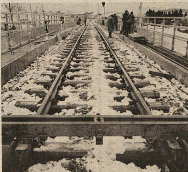
ŽELEZNICA BO RAZBREMENILA CESTE – Dela na velikem gradbišču na industrijskem tiru novomeške tovarne IMV gredo h koncu. V torek, tri dni pred otvoritvijo so delavci opravljali še zadnja dela na najsodobnejših signalnih napravah, da bo vožnja po tirih res varna. (Foto: J. Pavlin)
