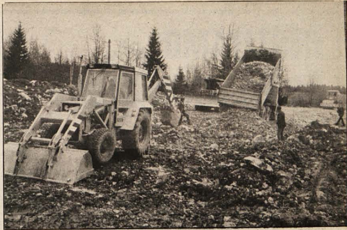
Gradbišče ceste Dvor - Kočevje
