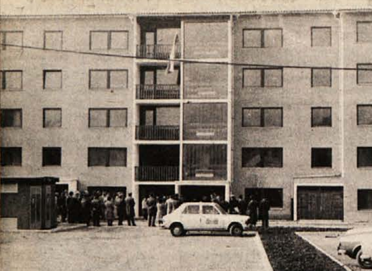
NOVA STANOVANJA — Prejšnji teden so v okviru praznovanj občinskega praznika v soseski Čardak v Črnomlju predali namenu 22-stanovanjski blok, ki so ga zgradili v sklopu družbeno usmerjene stanovanjske gradnje. Gradnja je veljala 14 milijonov dinarjev. V bloku je 12 solidarnostnih stanovanj, 10 pa jih je kupilo združeno delo. (Foto: A. Bartelj)
