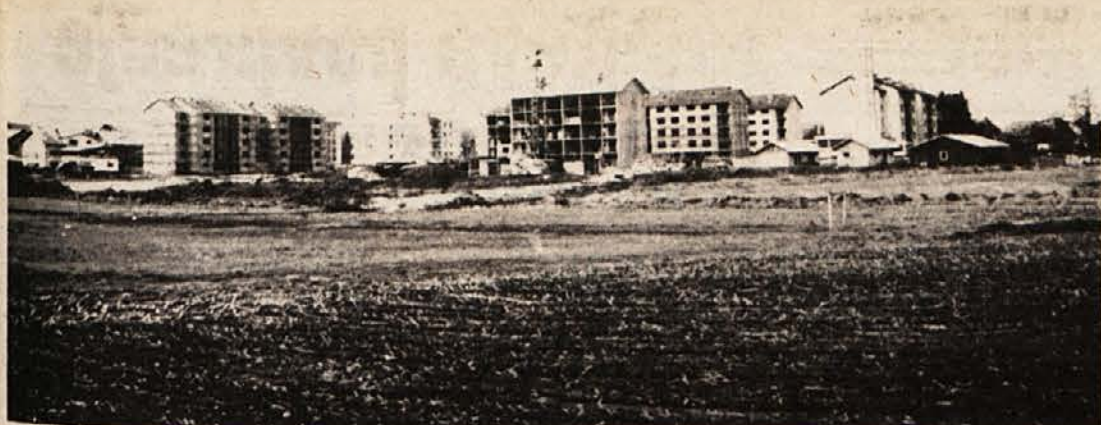
NOVA STANOVANJA – Delovni ljudje in občani so gotovo zainteresirani, da bi z denarjem, ki ga združujejo, zgradili čimveč in čim boljših stanovanj, razen tega pa tudi, da bo denar za vzdrževanje stanovanj pametno in gospodarno porabljen. Predlagatelji sporazumov naj jim zato prisluhnejo. Na fotografiji: nova stanovanjska soseska, ki raste za Ljubljansko cesto v smeri Marofa oz. Rinže. (Foto: Primc)
