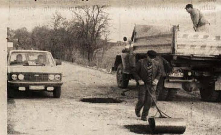
ZAKRPANA CESTA – Toplo, pravo spomladansko vreme je prejšnji teden na gorjansko cesto pred Metliko privabilo tudi delavce, ki so se po preizkušeni metodi – z asfaltno maso in lopatami – lotili številnih lukenj, ki jih je v gotovo ne preveč kvalitetno cestišče naredila neusmiljena zima.
