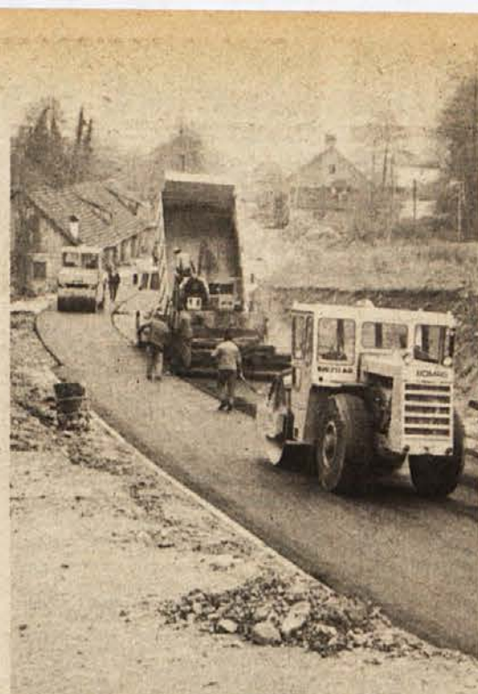
ASFALT PROTI ČABRU – Od Broda na Kolpi do Guče sela na cesti proti Čabru so položili te dni blizu 4 km asfalta, prihodnje leto pa bodo nadaljevali posodabljanje ceste do Kužlja. Tako se je končno le začelo resnejše posodabljanje ceste v zgornji Kolpski dolini. (Foto: Vardijan)
