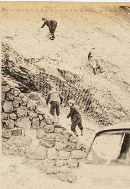
ZA VAREN PROMET – Na uradno zaprti „partizanski magistrali“ pri Starih žagah, kjer je zemeljski plaz dvakrat zasul cestišče, te dni delavci očisteno in zavarovano strmimo nad cesto prekrivajo z mrežo, da bo vožnja po lepi cesti res varna. (Foto: A. Bartelj)
