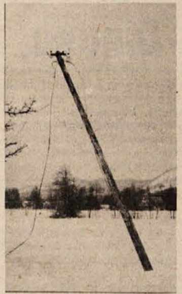
POTRGANA NAPELJAVA - na območju občine Ribnica je sneg naredil veliko škodo na električni in telefonski napeljavi, ki še dolgo ne bo popolnoma odpravljena. Na fotografiji: nagnjen drog in potrgane žice pri Gorici vasi. (Foto: Primc)
