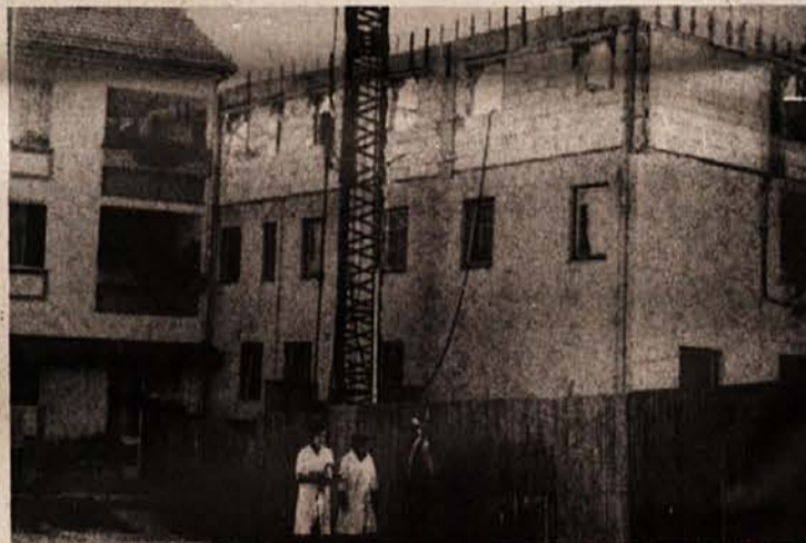
SPET ZIDAJO – Komaj so končali gradnjo novega prizidka metliškega doma počitka, že so začeli nadzidavati stavbo, v kateri so med drugim tudi upravni prostori. Nadzidek bodo povezali z novim prizidkom in tako bo druga faza obnove metliškega doma končana. Za prihodnje leto pa je v načrtu obnove starega gradu.
