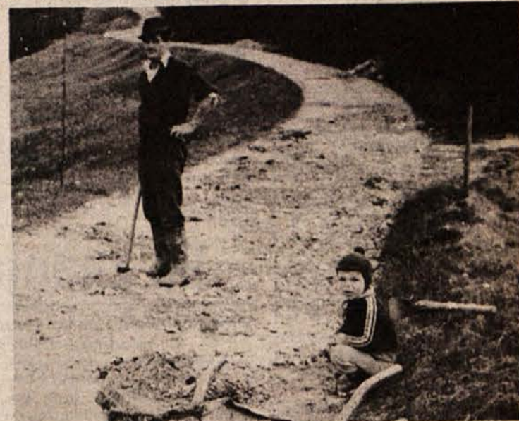
KRAJEVNE CESTE VSE SLABE — Krajevne skupnosti imajo velike težave z vzdrževanjem cest, za katere so dolžne skrbeti. Gre za makadamske ceste, po katerih se odvija precejšen promet. Tudi „honorarni“ cestar, ki ureja pot okrog Šentjošta, lahko le malo naredi. Manjka materiala, pa tudi samo z macolo ne gre kranje lukenj dovolj hitro. O kakšni modernizaciji dela na tem področju zaenkrat še ni govora. (Foto: R. Bačer)
