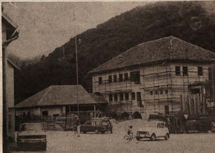
STANOVANJSKO-POSLOVNA STAVBA - V večjih krajevnih skupnostih v kočevski občini so dogradili ali dograjujejo stanovanjsko-poslovne stavbe. V KS Osilnica urejajo tako stavbo v nekdanji šoli, ki ji bodo nekaj prostorov tudi prizidali. (Foto: Primc)
