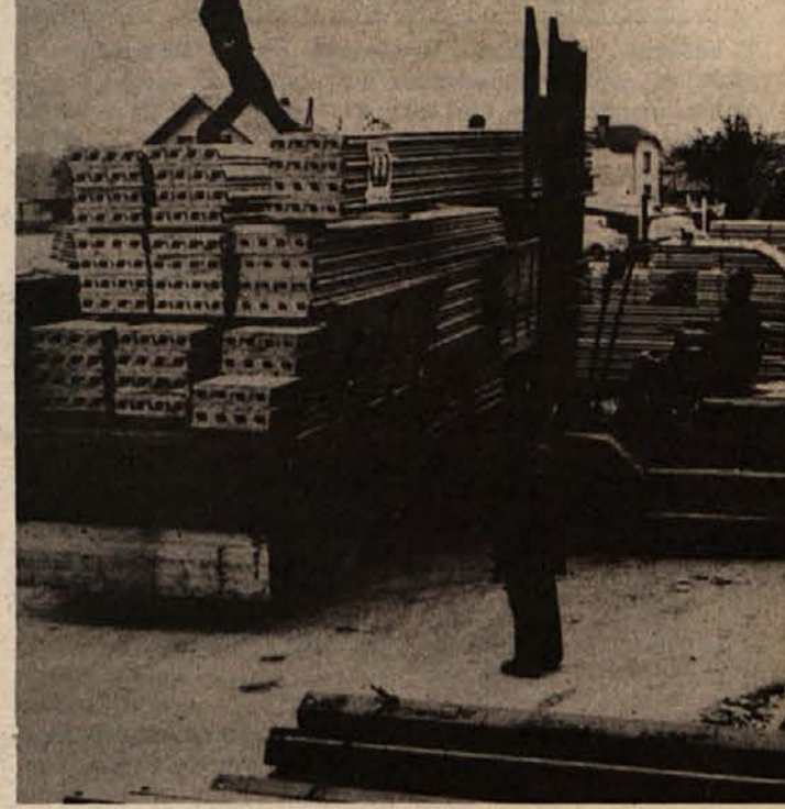
REDEK PRIZOR - Medtem ko so imeli v trebanjskem „Trimu“ spomladi težave z dobavo poliuretana - Soda iz Tuzle jim ga je obljubila, ne da bi v resnici to surovino, ki je za „Trimu“ izredno važna, tudi v resnici proizvajala - imajo zdaj težave s pločevino. Vsak dan bi potrebovali najmanj 30 ton pločevine, dobijo pa je le 60 do 70 ton na teden. Zaradi nerednih dobav pločevine - v celoti so vezani na uvoz, ker jim pločevine ne more dobaviti niti Skopje niti leskovački Lemined - so v zaostanku tudi pri kupcih. Zato so zdaj dobavni roki okoli 45 dni, povpraševanje po „Trimovih“ izdelkih pa je vsak dan večje. Zaradi vsega tega so taki prizori vedno bolj redki, zaradi nerednih dobav materiala pa ima delovna organizacija za 40 odstotkov manjšo proizvodnjo.
