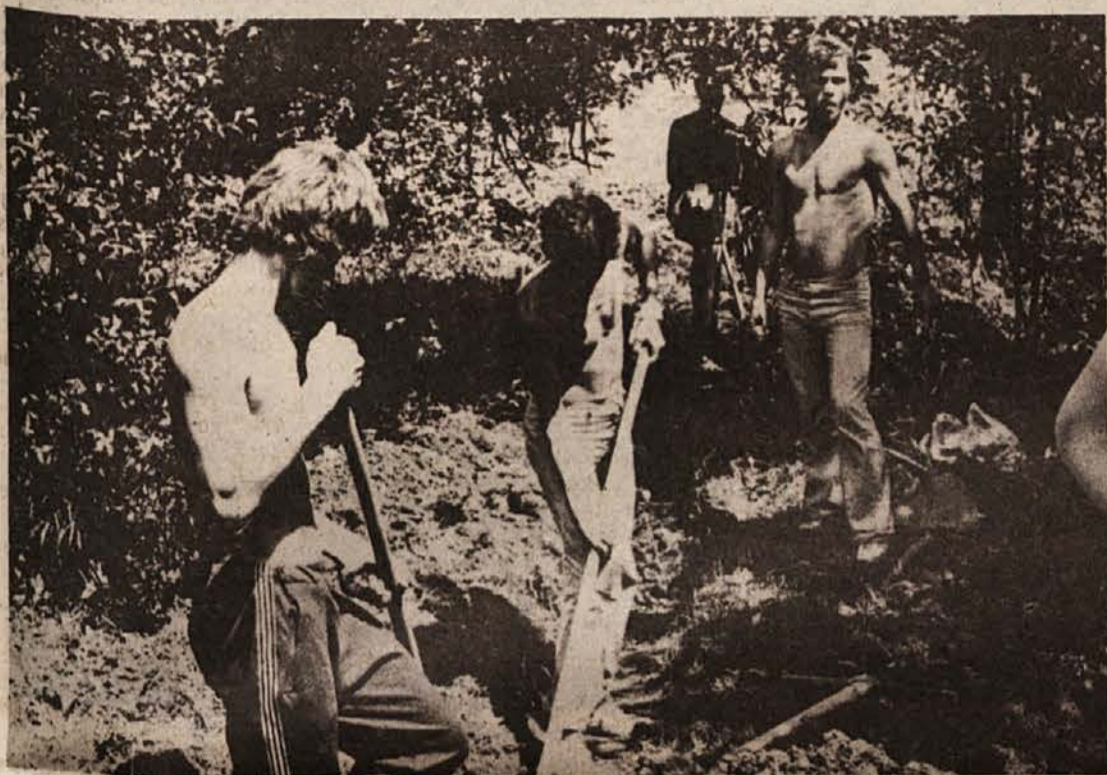
Gradnja vodovoda Dobnič
