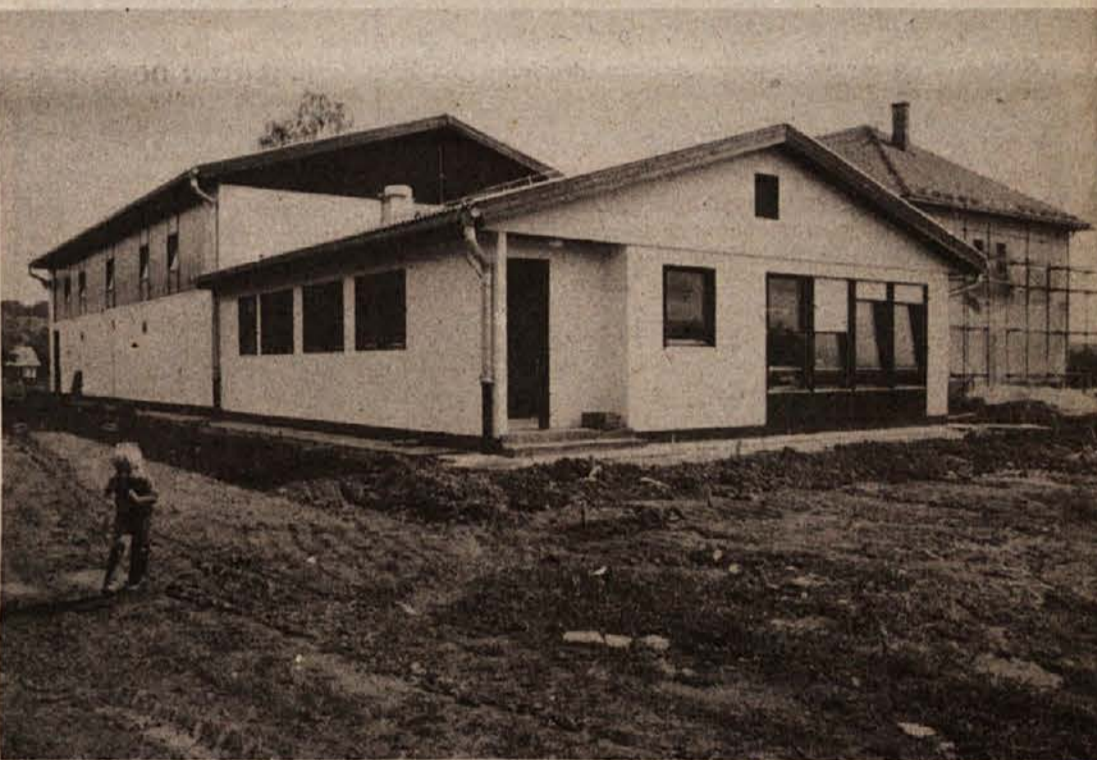
Prenovljena osnovna šola v Šentrupertu
