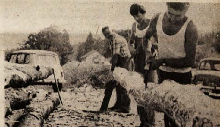
PILOTE ZAMENJUJEJO - Novogradovi delavci so začeli konec julija obnavljati zaloški most. Zamenjali bodo pilote ter pod na lesenem mostu. Predvidevajo, da bodo dokaj obsežna dela nared do 15. septembra, do takrat pa bo še naprej obvoz skozi Novo mesto oziroma Stražo. Na sliki: delavci obdelujejo pilot. (Foto: J. Pezelj)
