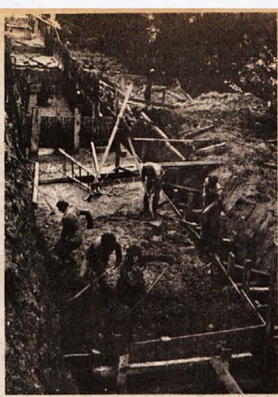
ŠE EN MOST – Celjski Ingrad je odprl veliko gradbišče novega mostu čez Savo in priključkov pri Radečah. Pridobitve se veselijo tudi v Loki v sevniški občini, ker bo premostil tudi železnico. Tam je doslej namreč ozko grlo za vse kraje pod Lisco. (Foto: Železnik)
