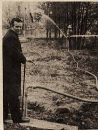
CEVI SO POLNE – Tako je brizgnila voda iz cevi, potem ko je Jože Škrbec odprl zaključni hidrant nižinskega vodovoda Sračnik – Sentjerneje. (Foto: J. P.)
