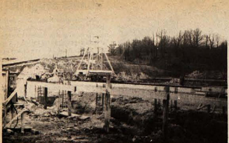
VELIKO GRADBIŠČE – Največji „parkirni prostor“, ki je precej časa sameval ob cesti, ki pelje iz Črnomlja na Stražni vrh, je zadnje tedne postal veliko gradbišče. „Gorenje“ iz Velenja gradi tovarno kompresorjev za hladilno tehniko, v kateri bo dobilo delo 180 ljudi. Začetek poskusne proizvodnje je predviden za jeseni.
