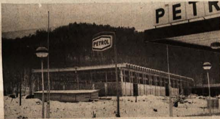
OTVORITEV ZA PRAZNIK DELA — Nova proizvodna dvorana Itasa ob Kolpi bo dokončana s približno trimesčno zamudo. Na fotografiji v ospredju se vidi tudi del nove bencinske črpalke, ki ji ne manjka štosti do dograditve. (Foto: Primc)
