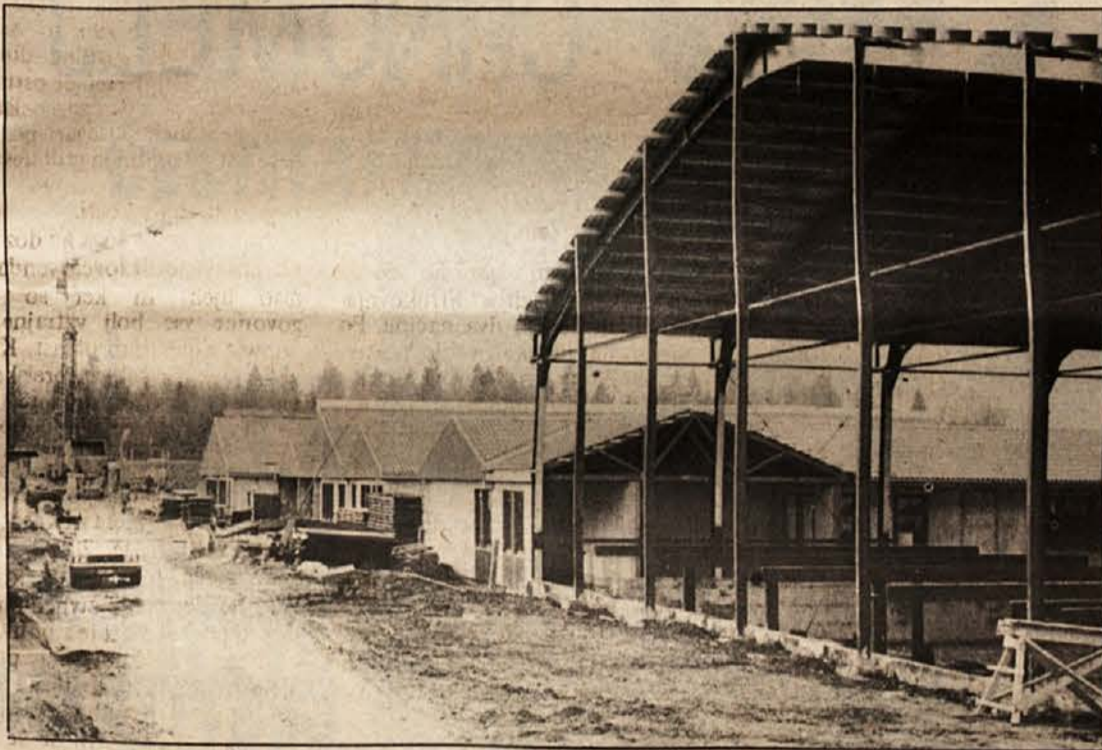
Gradnja Centra srednjih šol v Loki, v Črnomlju
