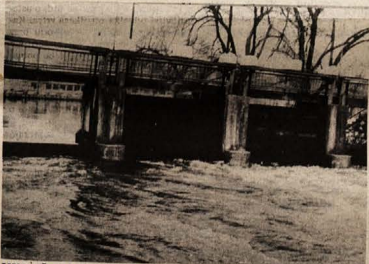
UKROČENA VODA - Zaradi uspešnega reguliranja vodnega stanja z zapornicami je Rinča skozi Kočevje hitro otekala. Tako nad zapornicami s poplavi ni povzročila škode, pod njimi pa le malenkostno. Na fotografiji: voda pod zapornicami v Kočevju je dosegla že skoraj isto raven kot nad njimi, čeprav je ob običajnem stanju tu za nekaj metrov nižja. (Foto: Primc)
