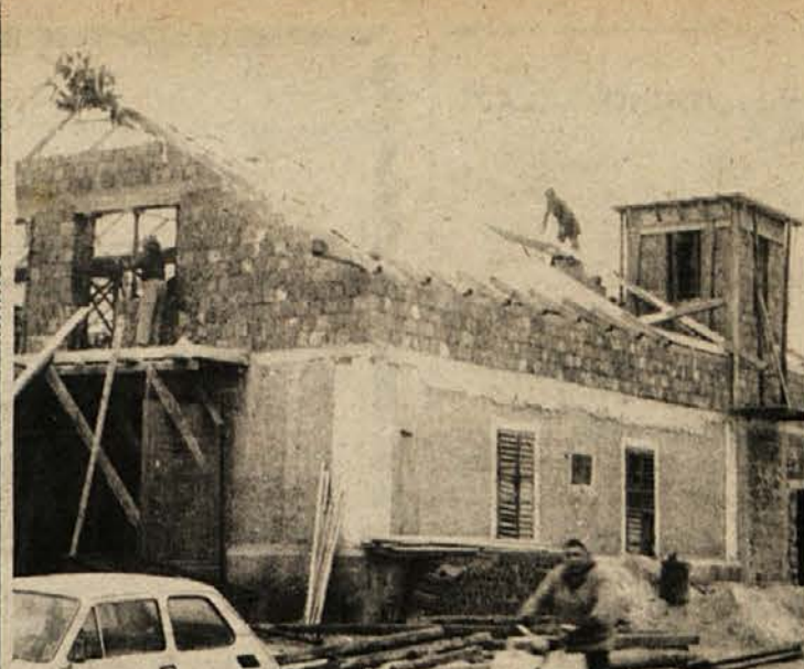
ZGLEDEN DOM — Šentruperški gasilci bodo s svojim prostovoljnim delom prišli do lepega doma. Stavbo so precej razširili in tudi dvignili. Spomladi bodo nadaljevali s preostalimi notranjimi obrtniški deli. (Foto: Železnik)
