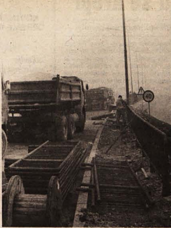
ZDRŽAL BO ŠE MARIKAJ — 15. decembra je Pionir kot graditelj brestaniškega mostu čez Savo opravil preizkus nosilnosti novogradnje. Na mostu je bila postrojena vrsta težkih tovornjakov s skupno težo 300 ton, pod čemer pa se železobetonski orjak vsaj na oko ni prav nič podal. (Foto: Železnik)
