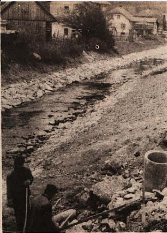
BREGOVI BISTRICE — V Sodražici so letos najprej zamenjali leseni most čez Bistrico z betonskim, zdaj pa urejajo še brežine Bistrice. Ko bo delo končano, bo Sodražica tudi bolj varna pred poplavami. Prav lani je namreč poplava povzročila veliko škodo. (Foto: J. Primc)
