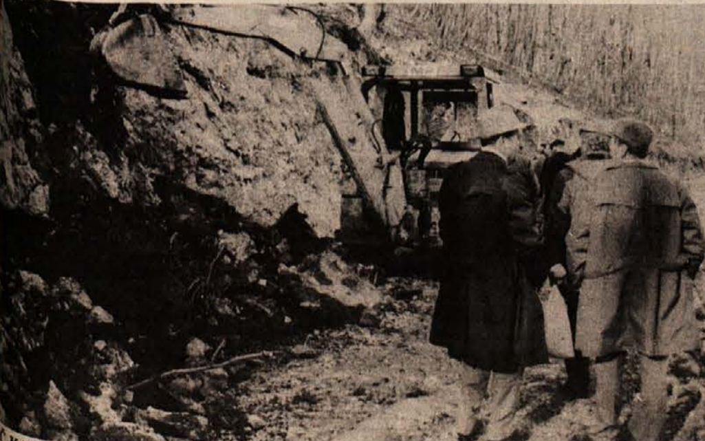
KAMENJA KOT ZEMLJE — Delo na trasi je težavno, ker morajo stroji izkopati več kamenja kot zemlje.
